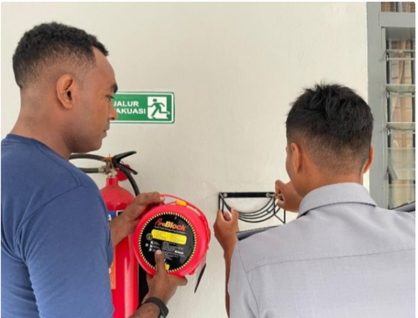
Antisipasi Kebakaran, Lapas Besi Tambah Pemasangan Fireblock
