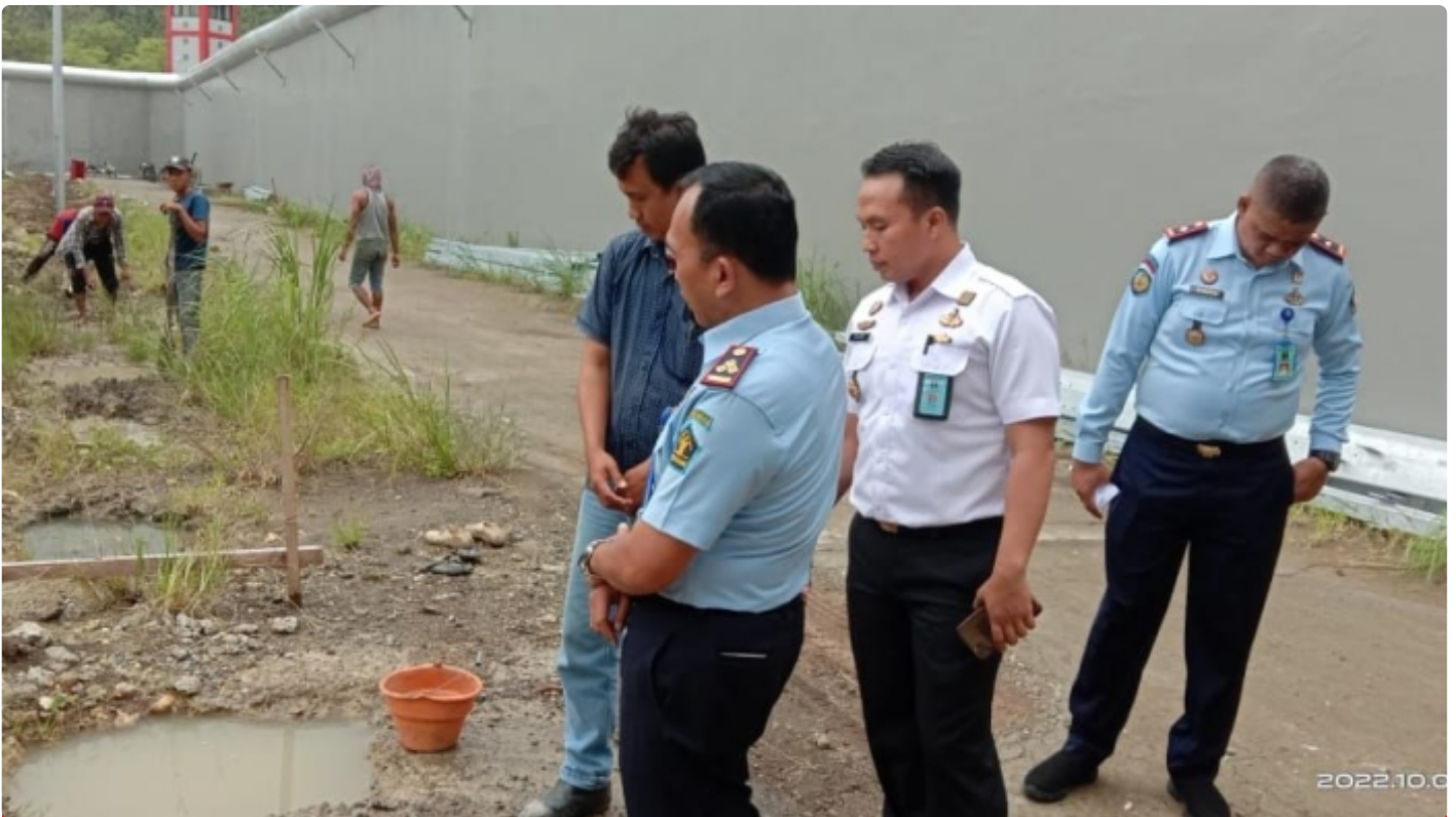
Kalapas Cilacap Laksanakan Monitoring Progres Pembangunan 3 Lapas di Nusakambangan
